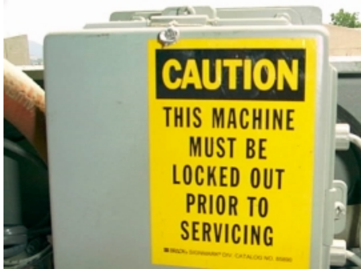
Spojna kutija kablova mjernih pretvornika
